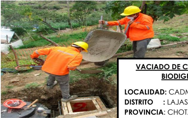
**VACIADO DE CONCRETO EN BIODIGESTOR**
