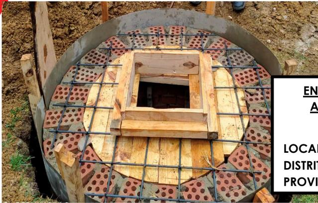
**ENCOFRADO Y ARMADO DE ACERO EN TAPA DE POZO PERCOLADOR**
